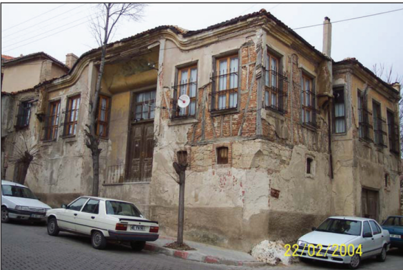
Resim 1. Kırklareli Geleneksel Konutlarından Hımiş Yapı Örneği
