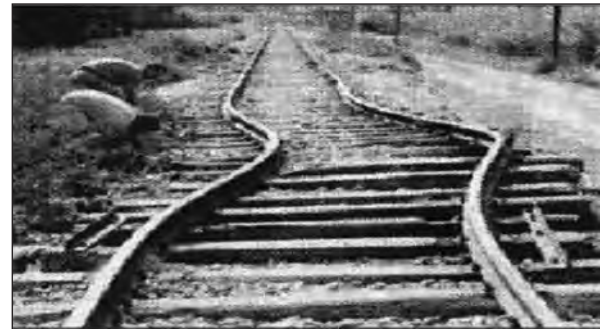
Resim 3. Yanlış Montajın Sebep Olduğu Malzeme Termal Genleşmesi [3]
