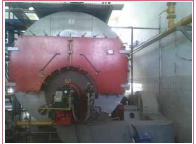
Şekil 1. Skoç Tipi Doymuş Buhar Kazanı
