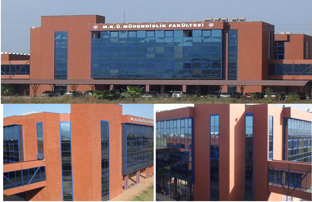
Resim 2. MKÜ Mühendislik Fakültesi Binası Ön ve yan görünüşleri[7]
