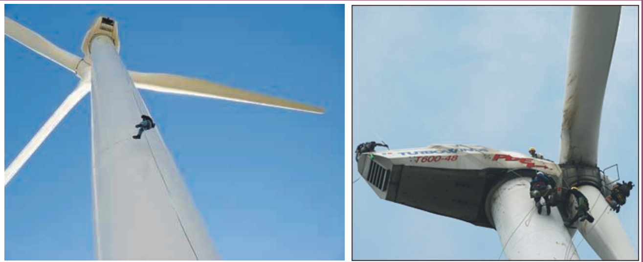
Şekil 3. Türbin Kulesinde Yapılan Bazı Bakım İşlemleri
