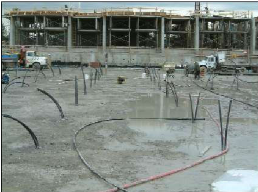
Şekil 5. Kuyu içi ısı değiştiricilerinin yerleşimi (Eksenler arası: 4.5 m)
