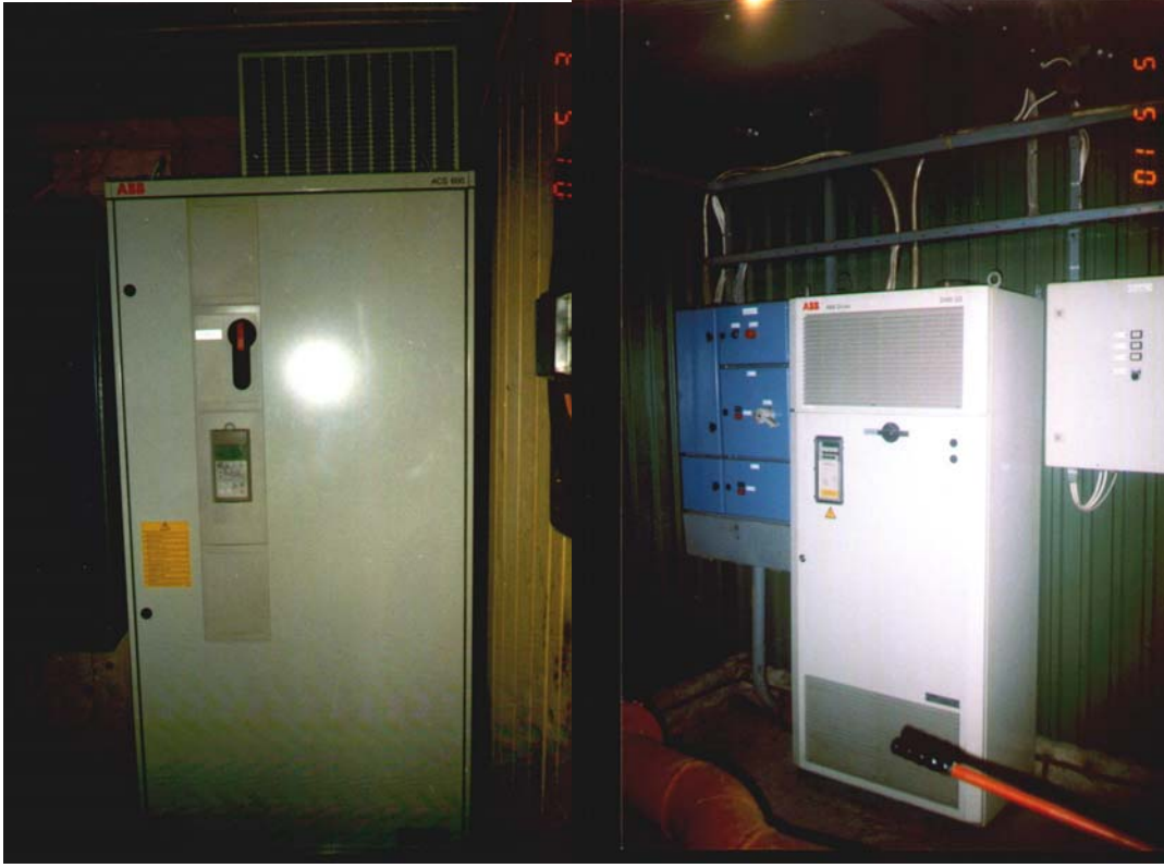
Şekil 24. Oradea Üniversitesi Jeotermal Bölgesel Isıtma Sistemi, frekans konvertörleri.
