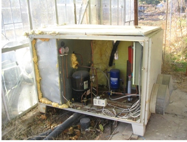
Şekil 6. Isı pompası Görünüşü ve Su Giriş ve Çıkış Noktaları
