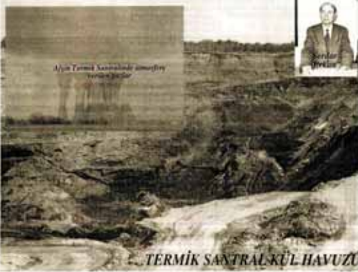
Alpaz Termik Santralinde santrallerin kurulacağı yer. TERMİK SANTRAL KÜL HAVUZU
