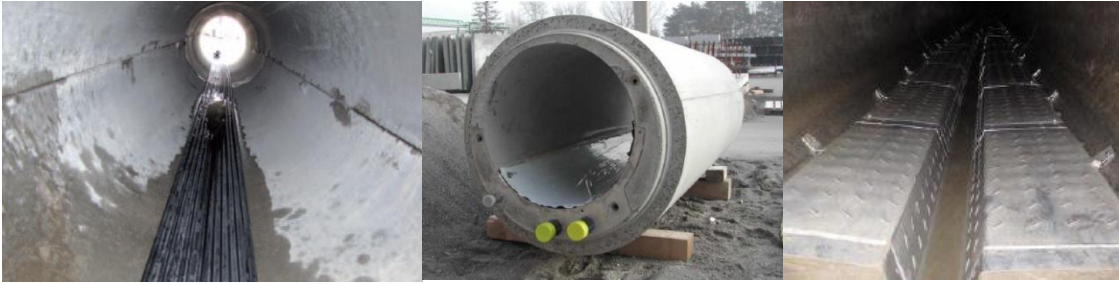
Şekil 8. Kanal yatağına yerleştirilmiş ısı değiştirici uygulamaları [16,17-18]
