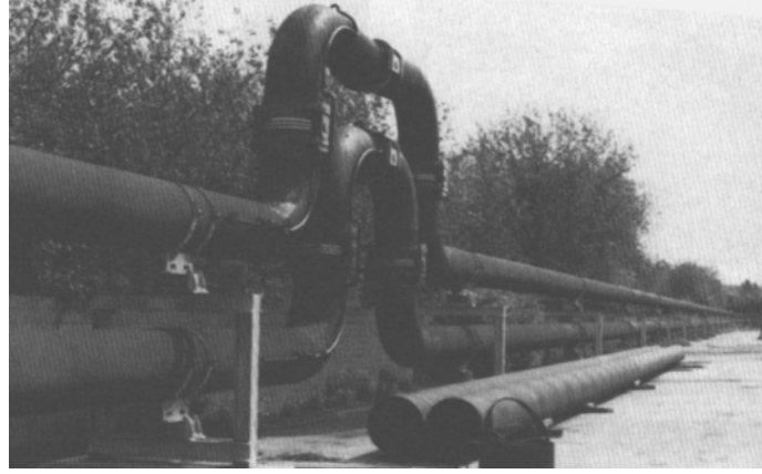
Sekil 8. Normal U dengeleyicisi
