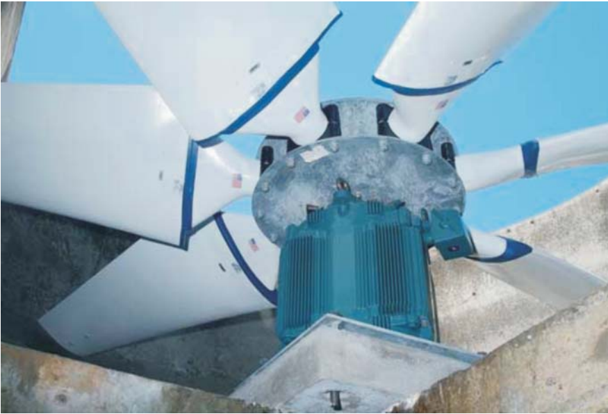
Baldor'un yeni motoru doğrudan fanların üstüne etki yaparak, vites kutusu ve tahrik milini gereksiz kılıyor.
