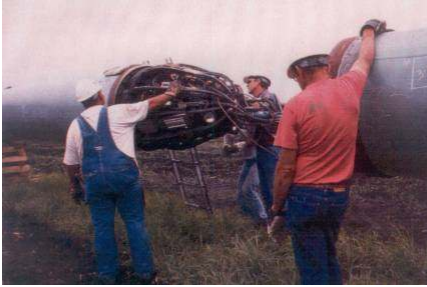
Şekil 4. Kök Pasonun Kaynağı İçin Otomatik İç Kaynak Makinasının Yerleştirilmesi
