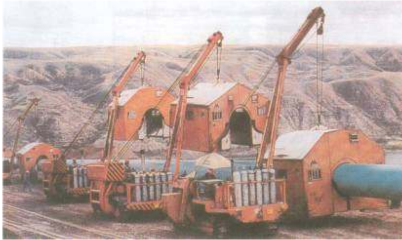
Şekil 1. Portatif Kaynak Kulübesi Yardımı İle Koruyucu Gazın Esen Rüzgarlardan Uçmadan Etkili Kullanımı.
