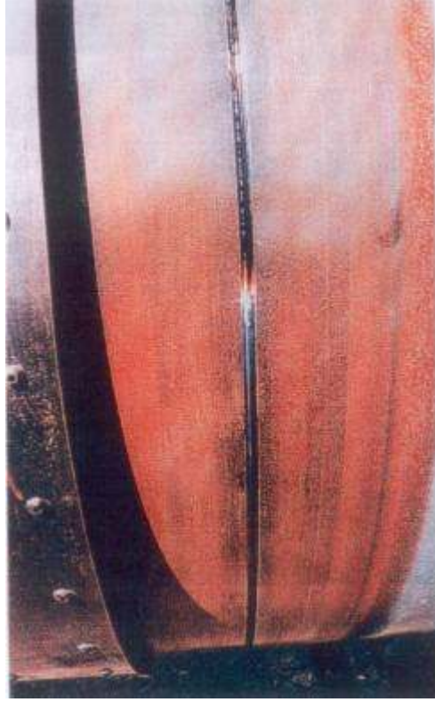
Şekil 5. Otomatik İç Kaynak İşlemi ile Kök Pasonun Yapılışında Arkın Dışarıdan Görülerek Kontrolü
