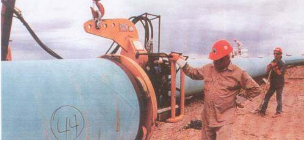
Şekil 3. Boruların Ağızlanmasında Kullanılan Makina ve Kullanımı
