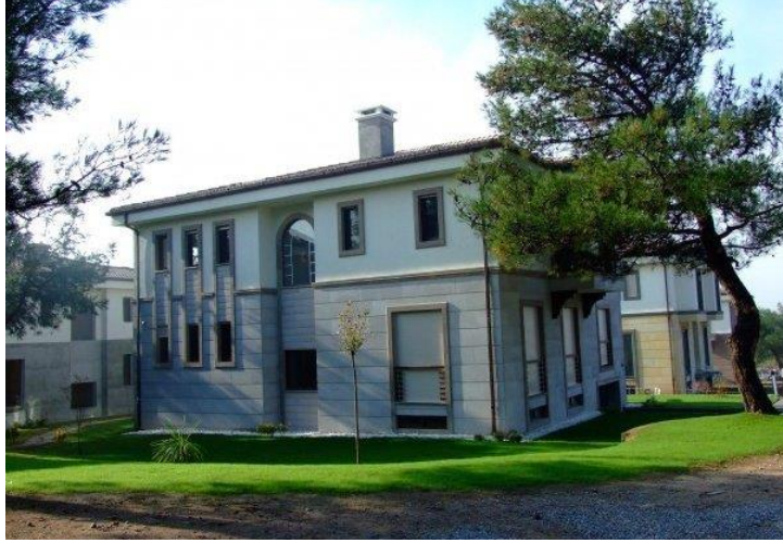
Şekil 1. İzmir, Buca, Kaynaklar’da yer alan müstakil konutun kuzeydoğu cephesi.
