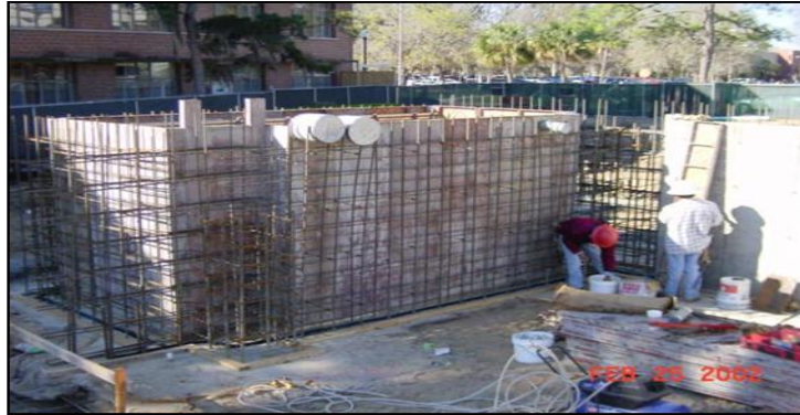
Şekil 3. Florida Üniversitesi'nde Rinker Hall Yağmur Suyu Toplama Sisteminin İnşaat Hali.
