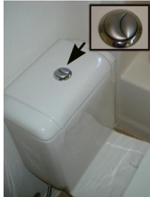
Şekil 1. Çift sifonlu İfö Cera tuvalet, yarım bir sifon için 1,1 litre, tam sifon için 6 litre su harcar. Sifon seviyeleri aşağı ve yukarı ayarlanabilir.
