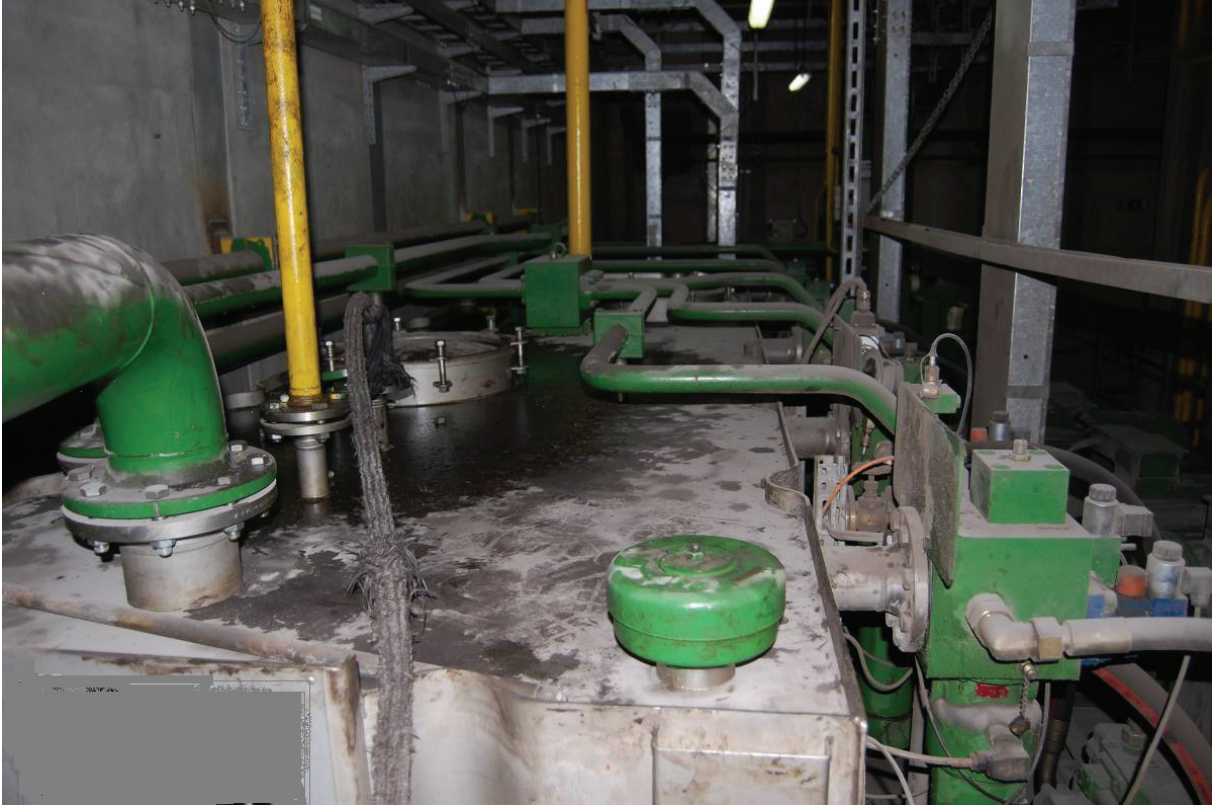
Şekil 5. Pota Sürgü Hidrolik Tankı
