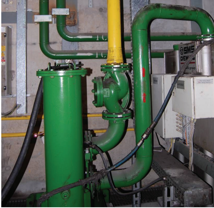
Şekil 7. Dönüş Hattı Filtresi
