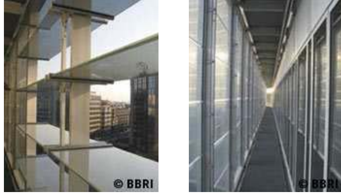
Şekil 5. Doğal Havalandırmalı Çift Kabuk Cephe Örneği [16]
