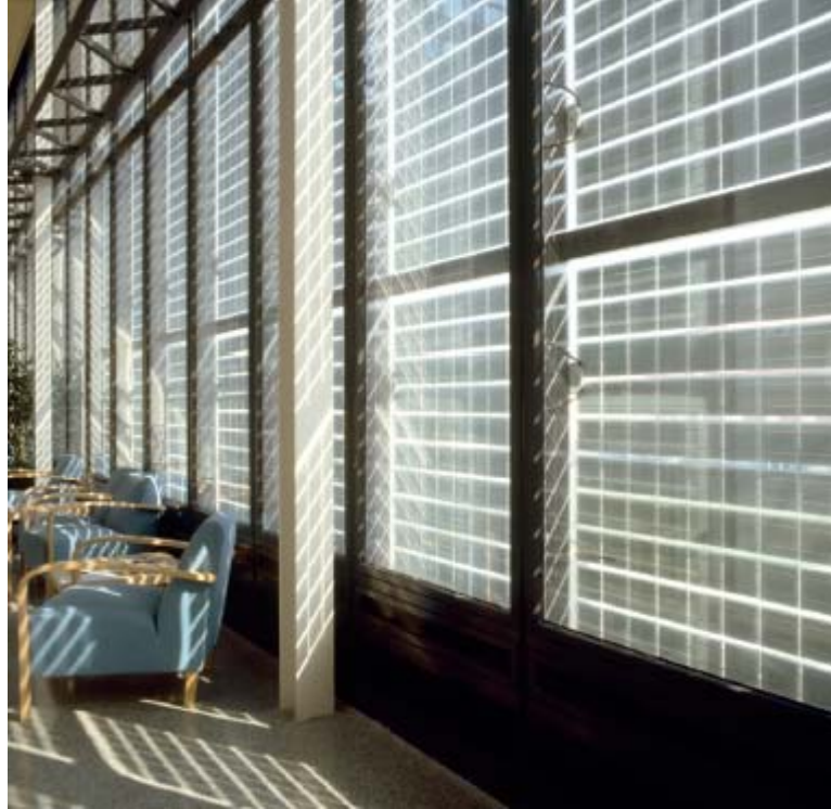
Şekil 14. Farklı Çift Kabuk Cephe Sistemlerinde Binaya Entegre PV Uygulaması [23].
