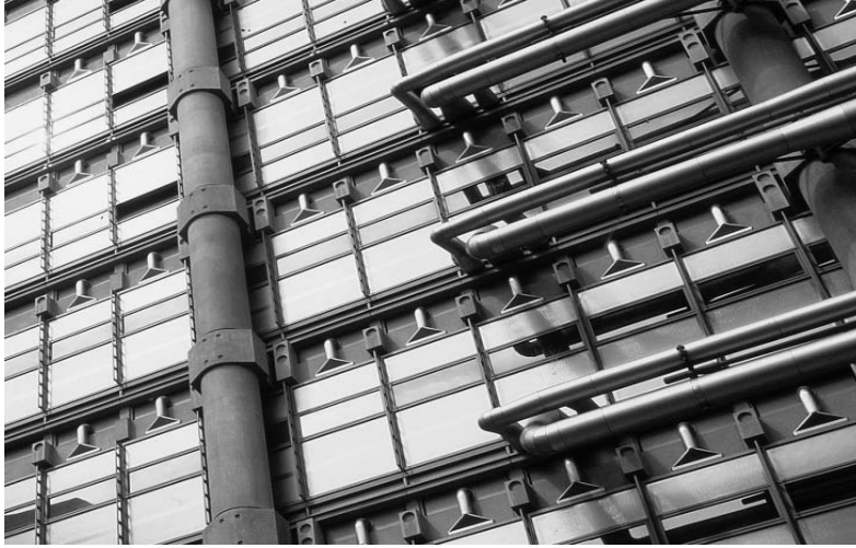
Şekil 2. Lloyds of London Binası Dış Cephe Görünüşü [4].
