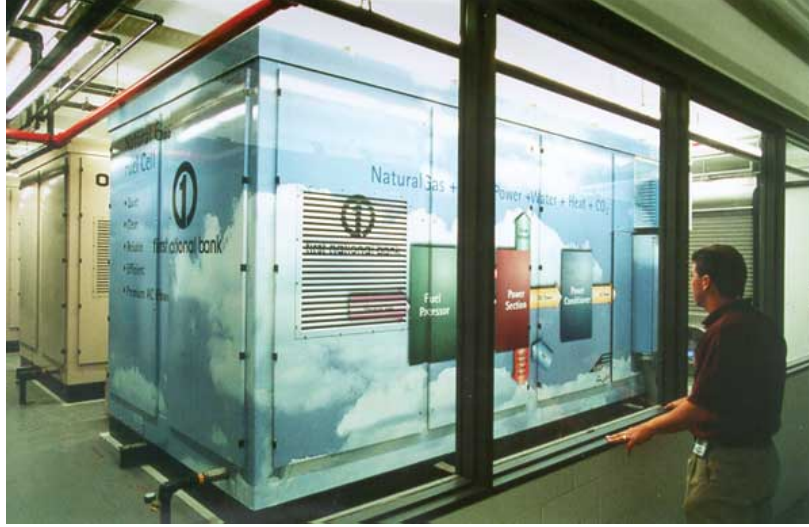
Şekil 18. Fosforik Asit Yakıt Pili Banka Bilgi İşlem Merkezi Kesintisiz Enerji Kaynağı Uygulaması [1]
