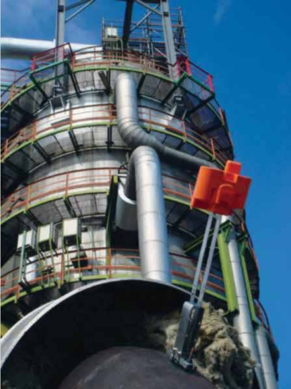
Permasense korozyon izleme sensorları ve vericileri, sahip olduğu iki dalga kılavuzu sayesinde boru duvarından uzak durarak araç ve aletleri aşırı sıcaklıklardan koruduğu gibi borudan ultrasonik dalgalar alma ve verme özelliğine sahip.
