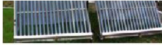
Şekil 2. Isı toplama ünitesi.
