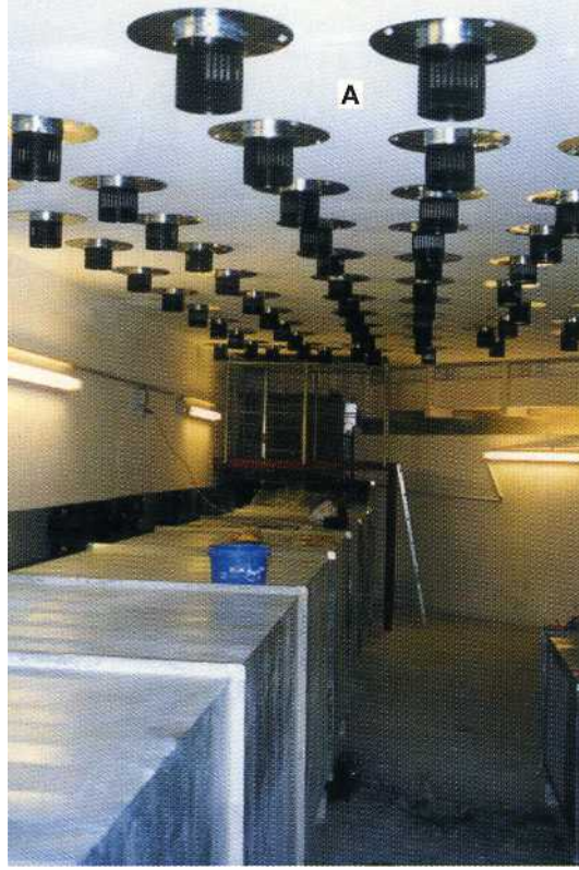
Şekil 10. Döşeme Dağıtıcılarının Yerleştirilmesi
