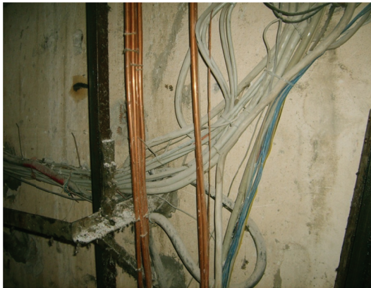
Örnek 3: Asansör boşluğunda bulunmaması gereken tesisatlar.Asansör boşluğunda yüksek gerilim kabloları ve tıbbi gaz boru tesisatı tehlikeli durumda bulunuyor.
