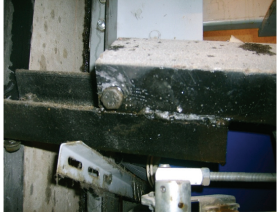
Örnek 2: Uygun olmayan saptırma kasnağı yan yatağı montajı. Saptırma kasnağı mili yan yatak olarak kullanılan U profilini U profili mili ciddi oranda kesmiş.halatlarda hasarlar var.
