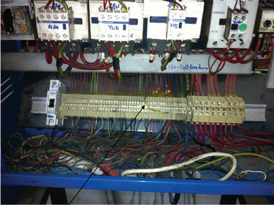
Sonradan kaynatılan ek lama
