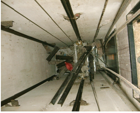
Örnek 2: Uygun olmayan saptırma kasnağı yan yatağı montajı. Saptırma kasnağı mili yan yatak olarak kullanılan U profilini U profili mili ciddi oranda kesmiş.halatlarda hasarlar var.
