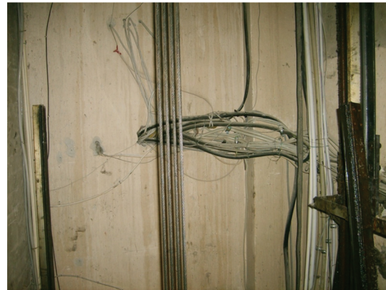
Örnek 3: Asansör boşluğunda bulunmaması gereken tesisatlar.Asansör boşluğunda yüksek gerilim kabloları ve tıbbi gaz boru tesisatı tehlikeli durumda bulunuyor.
