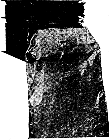
Şekil 12. Nükleer teknik tesislerinde Kanal içine monte edilebilen bir yüzer partikül filtresi (DELBAG)
