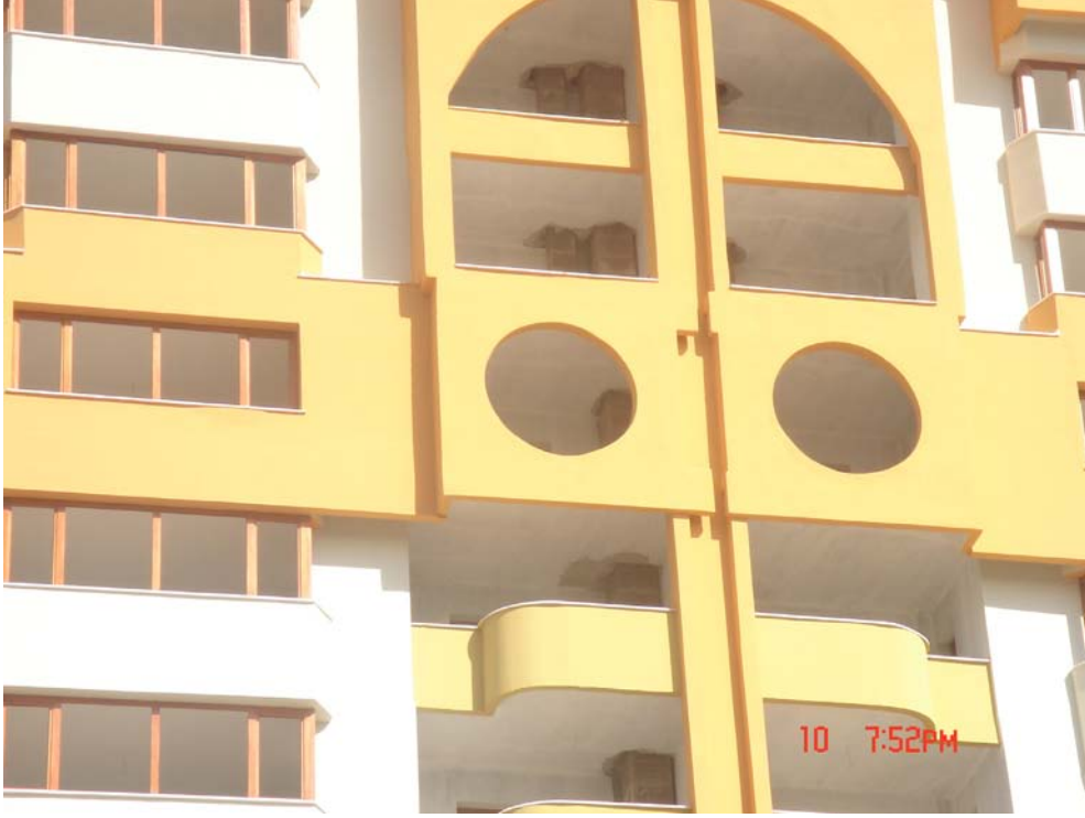
Şekil 116. Atık Gaz-Hava Bacaları
