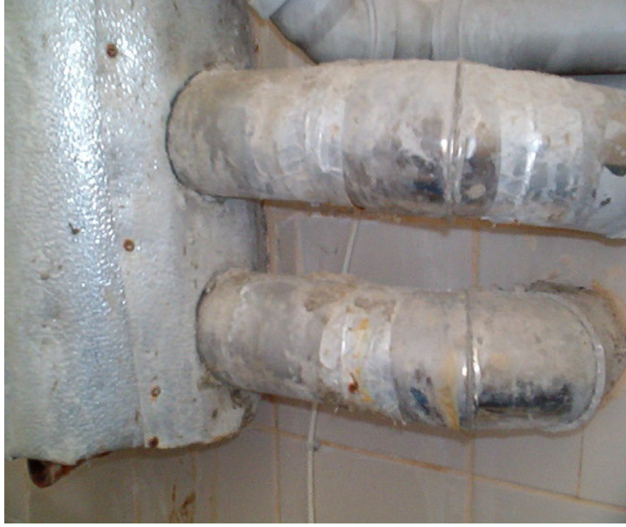
Şekil 79. Hatalı Bağlantılar
