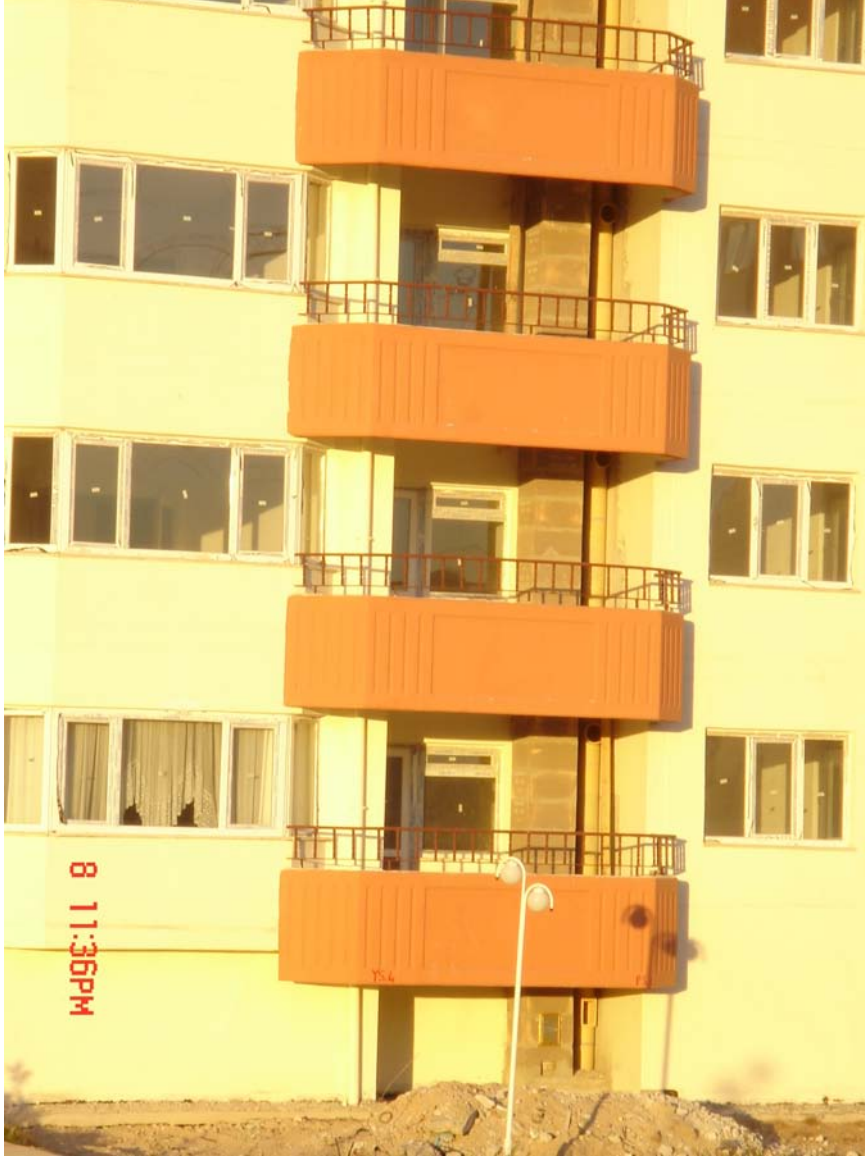
Şekil 115. Atık Gaz-Hava Bacaları
