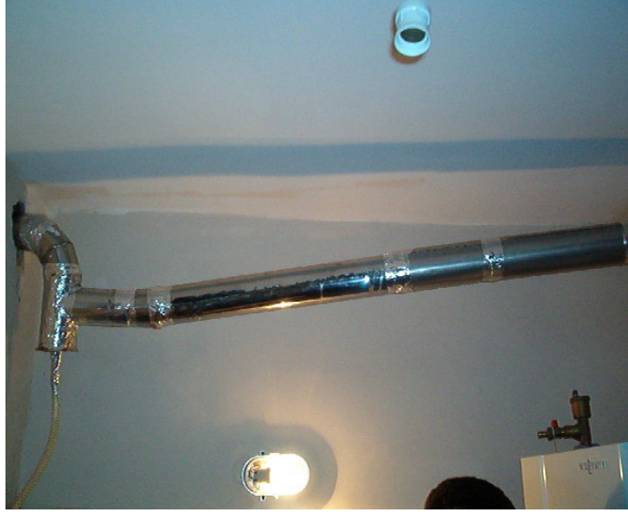
Şekil 73. Yanlış ürün - Hatalı Konstrüksiyon
