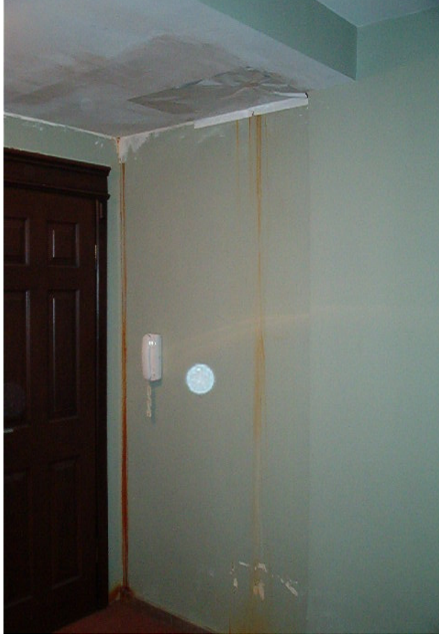
Şekil 70. Mevcut Sorun : Paslanma
