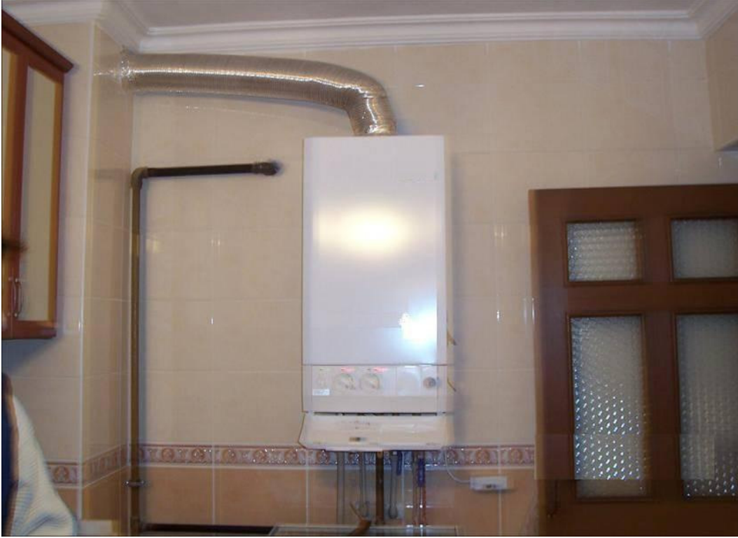
Şekil 48. Gereğinden Uzun Tutulan Yatay Mesafe ve Hızlandırma Mesafesine Dikkat Edilmeden Yapılan Bir Uygulama.
