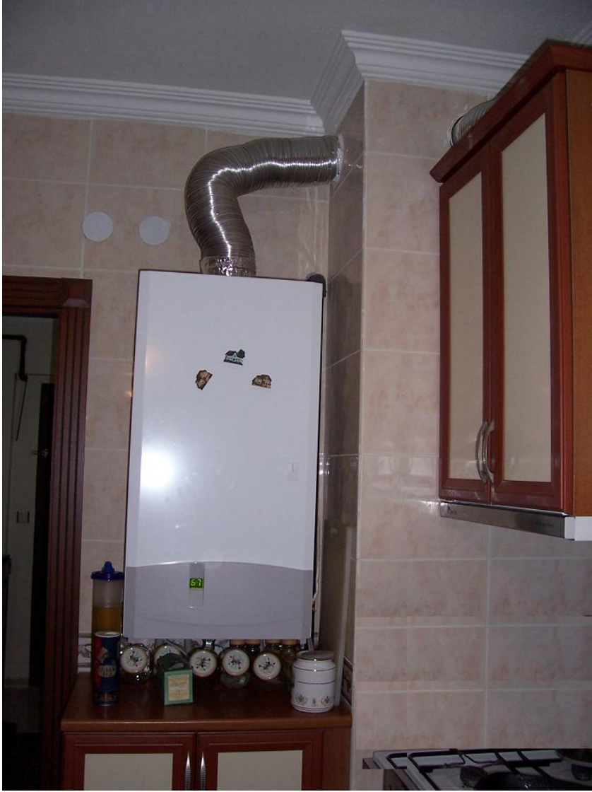
Şekil 47. Keskin Dirsekler ve Hızlandırma Parçasına Dikkat Edilmeksizin Yapılan Bir Montaj Örneği.
