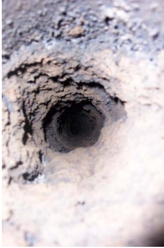
Şekil 45. Yetersiz Baca Çekişi Sebebiyle Oluşan Bozuk Yanma ve Sonucunda Kurum Dolarak Tıkanmış Bir Baca.
