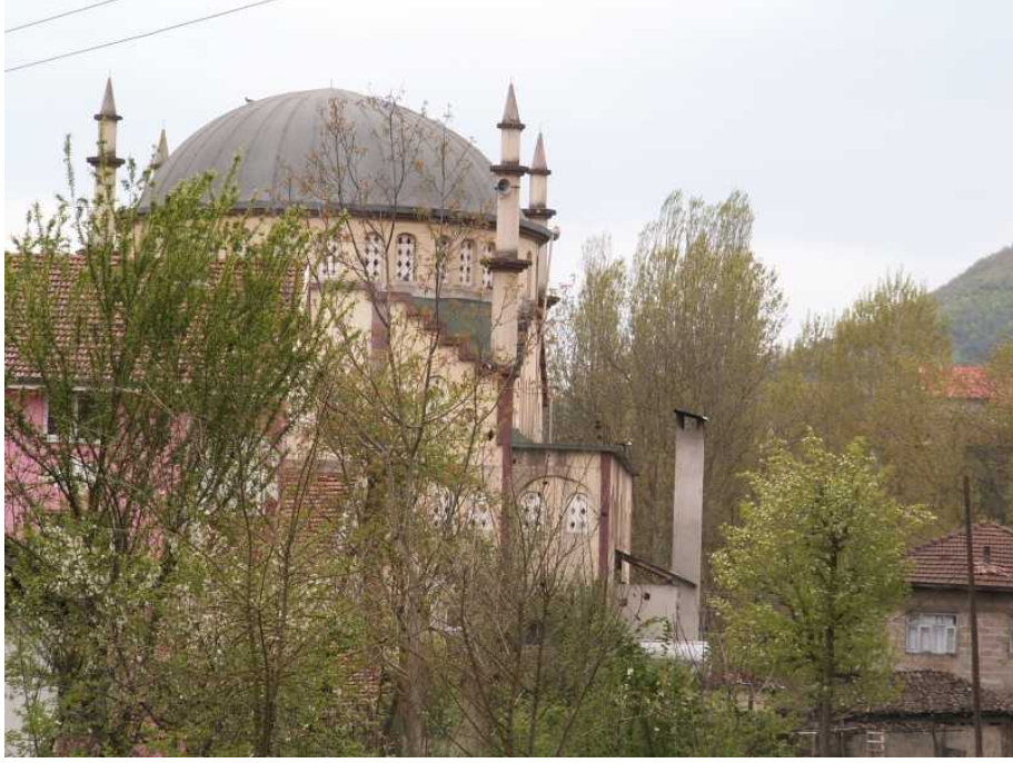
Şekil 62. Yersiz Baca Yükseklikleri ve İzolasyon Bacalarda Çekiş Sorunlarına Neden Olmaktadır.
