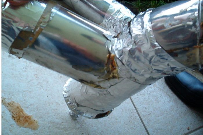
Şekil 76. Yanlış ürün - Hatalı Konstrüksiyon
