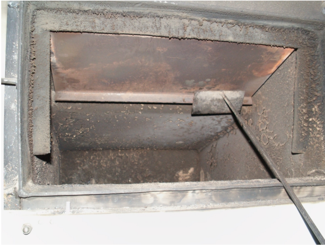
Şekil 44. Yetersiz Baca Çekişi Yanma Veriminin Düşmesi ve Kurumlanmaya Sebep Olacaktır.
