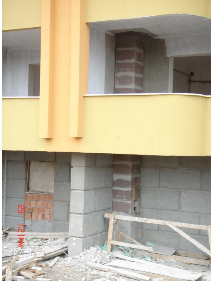
Şekil 111. Atık Gaz-Hava Bacaları
