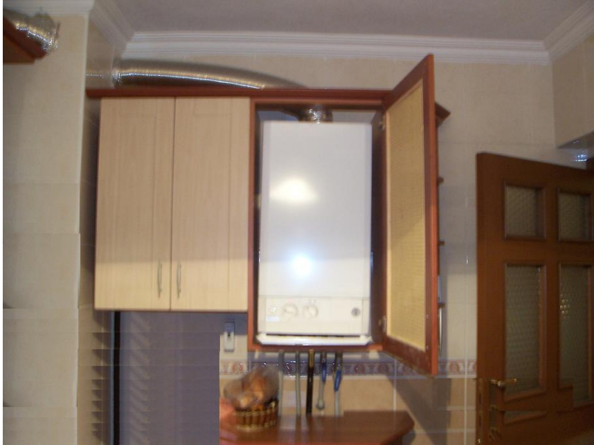
Şekil 46. Gereğinden Uzun Tutulan Yatay Mesafe ve Hızlandırma Mesafesine Dikkat Edilmeden Yapılan Bir Uygulama.
