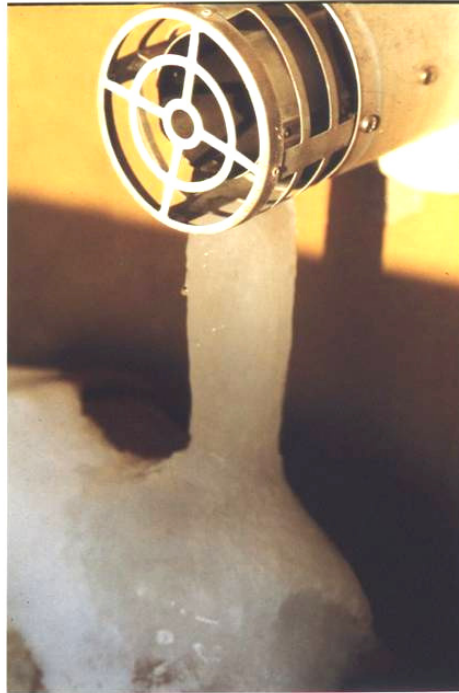
Şekil 86. Hermetik Baca Hatalı Uygulamaları
