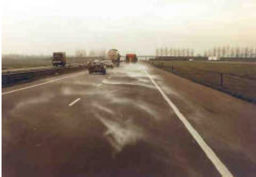
Resim 2. Islatılmadan serilmiş tuz.
