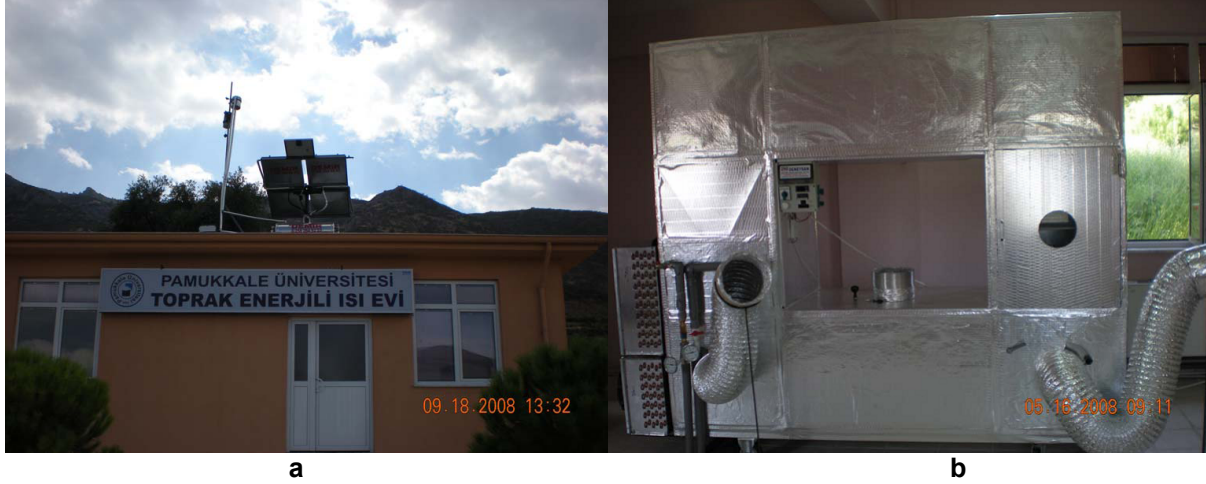
Şekil 5: Güneş enerjisi sıcak su sistemi, meteoroloji istasyonu(a) ve kurutma sistemi(b).
