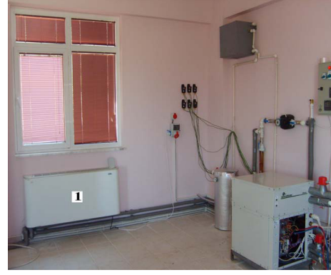
Şekil 3: Fan-coil ünitelerinin yerleşimi.
