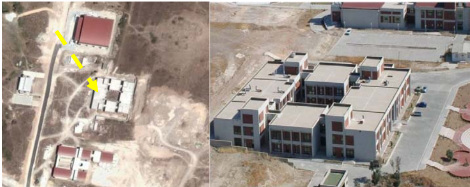
Şekil 16. SKS Binası Hava Fotoğrafı ve Görünüşü.
