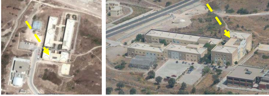
Şekil 7. Fen Fakültesi A Blok binası Hava Fotoğrafı ve Görünüşü.
