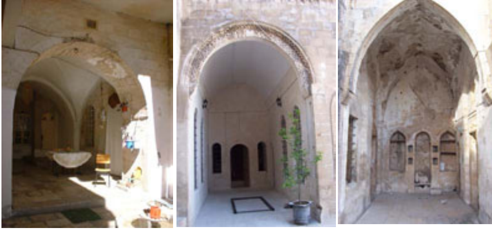
Şekil 7. Avlu, eyvan, havuz (Kasımiye Medresesi) ve odalar arası geçiş ögesi olarak eyvan örnekleri
