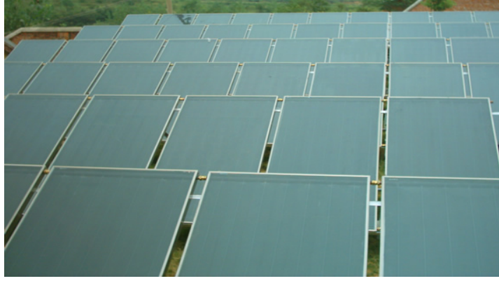
Şekil 10. Isı toplama ünitesinde düzlem güneş toplaçlarının düzenlenmesi
