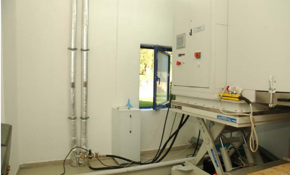
Resim 7. Binaya Gelen Ana Kolon Borusu ve Bir Test Kabinine Ayrılan Yan Kol [1]
