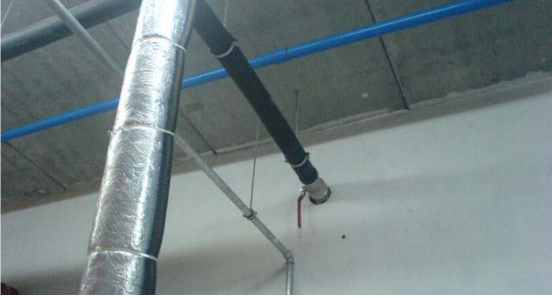
Resim 3. Depodan Emilen Suyun Depoya Üstten Geri Boşaltılması [1]
