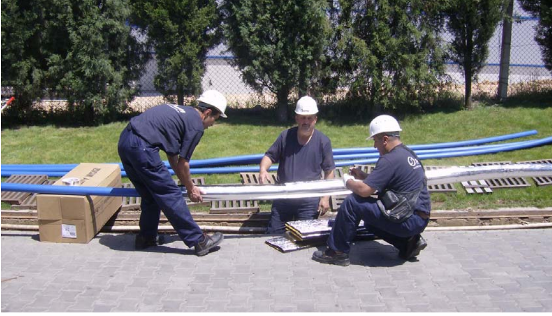
Resim 6. Isı Pompası Makine Dairesinden Test Kabinleri Binasına Kadar Döşenen Polietilen Borular [1]
