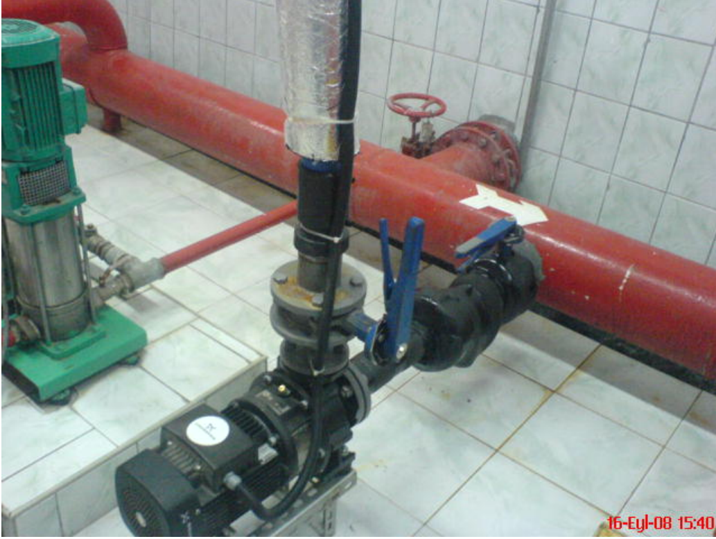
Resim 2. Yangın Hattından Emiş Yapan Kaynak Tarafı Pompası [1]
