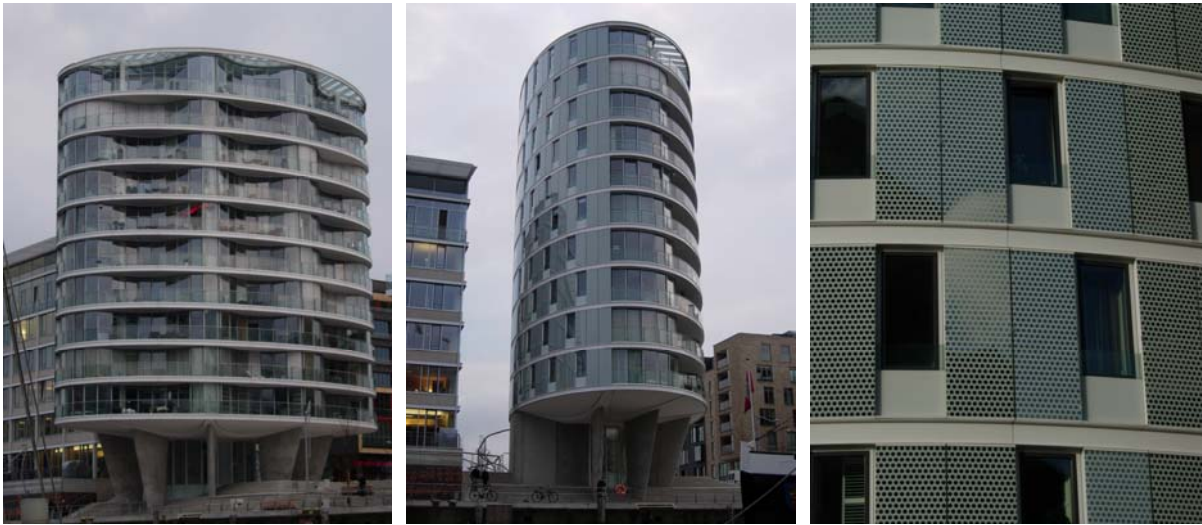
Resim 4. Hafencity - Oval bina, Batı, Kuzey Cephe ve Doğu Cephe Detayı (T. Göksal Özbalta arşivi)
