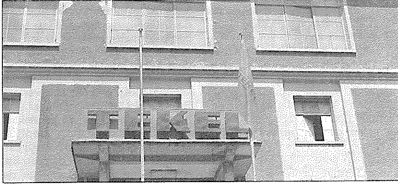
1986'dan beri yatırım yapılmayan KİT'lerin binaları bile terk edilmişliği çağırıyor.
