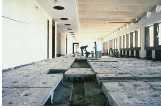
Şekil 14. The Eastgate Centre Binası'nda Prekast Döşeme Uygulaması [20]
