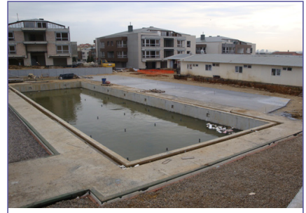
Dikey borulama yapılan alan
