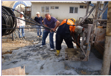
Açılan sondaj kuyusuna boru indirilmesi
