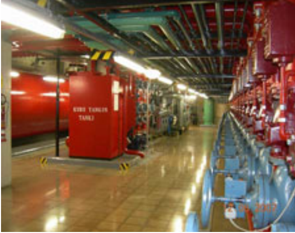
Şekil 29. Sprinkler santrali
