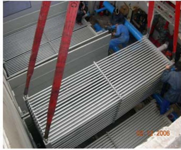
Şekil 4. Soğutma kulesi yenileme çalışmaları
