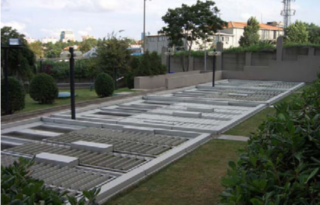
Şekil 2. Soğutma kulesi, Mayıs 2003
