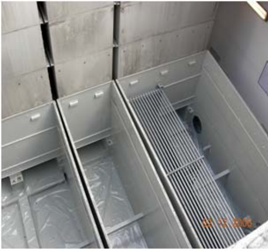
Şekil 3. Soğutma kulesi yenileme çalışmaları
