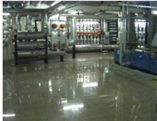
Şekil 22. Holding kule 1 No'lu havalandırma santrali
