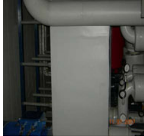
Şekil 18. Termal kamera ile soğutma sisteminde enerji tasarrufu için soğuk izolasyon yapılan ısı eşanjörünün kontrolü
