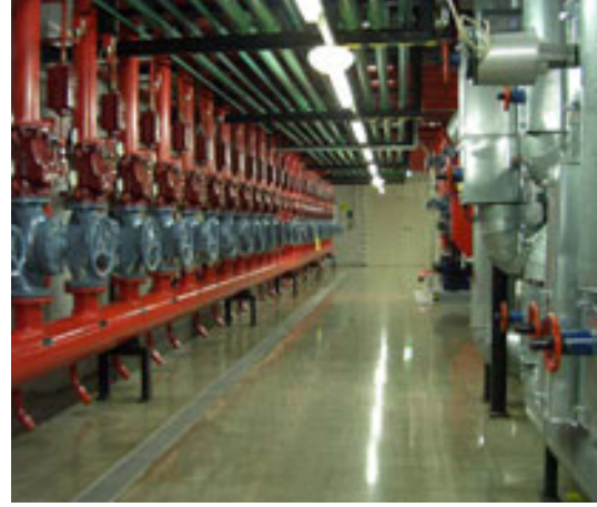
Şekil 20. Sprinkler santrali
