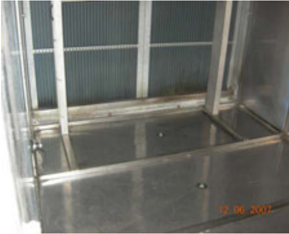
Şekil 25. 14 Yıllık klima santralleri içinden görünüm
