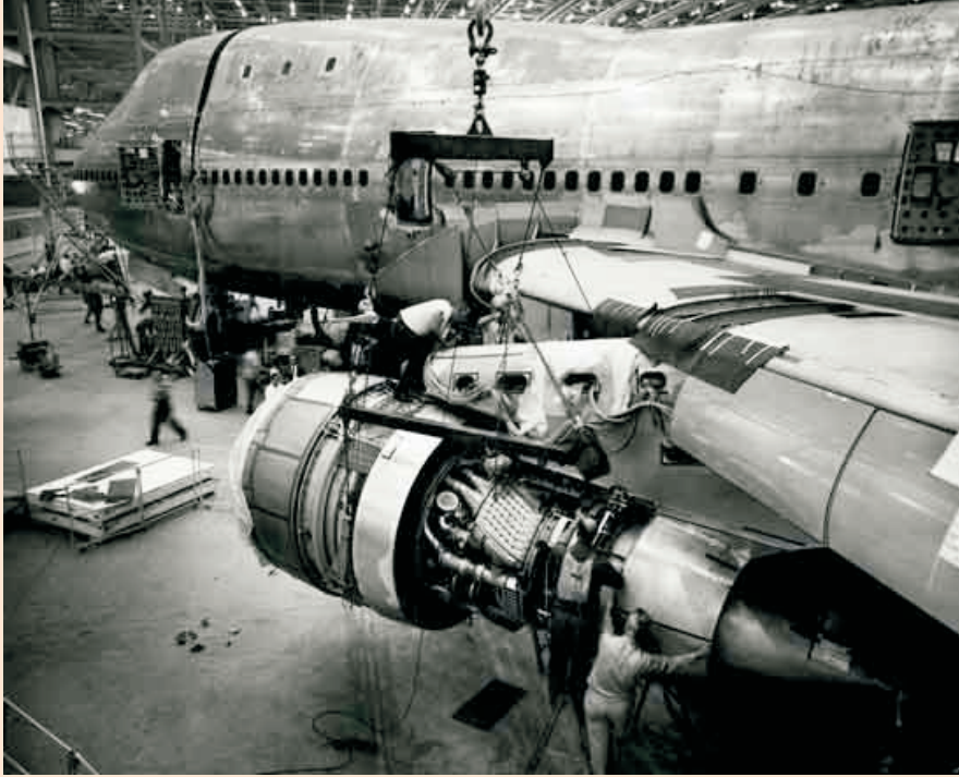
Motor bölmesi içindeki bir Pratt & Whitney Aircraft JT9D jet motorunun No. 1 Boeing 747'nin sol kanat pilonu üzerine monte edilmesi, 4 Eylül 1968.
