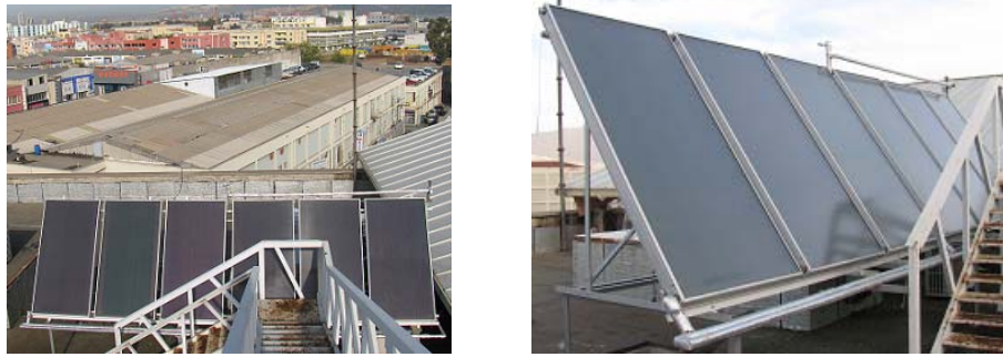
Resim 4: Güneş Kolektörlerinin Çatı Montajı
