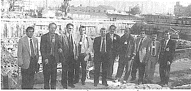
Teknik gezilerden biri de Şubemiz İş ve Sosyal Hizmet Binası inşaatına yapıldı.
