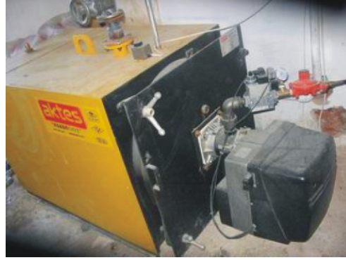
Şekil 8. Ana Isı Merkezinde Kombi ve Brülör
