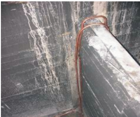
Şekil 7. Biyogaz Reaktörünün İçten Görünüşü
