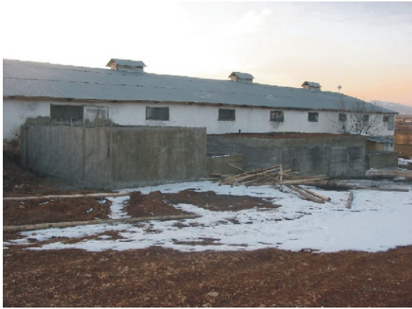
Şekil 6. Gübre Ön Havalandırma Ünitesi, Gübre Besleme Rogarı, Reaktör ve Gübre Çıkış Ünitesinin Görünüşü
