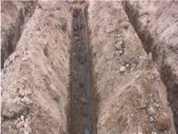
Şekil 2. Toprak Altı Isı Değiştirgeci Devresinde Boruların Toprağa Serilişi
