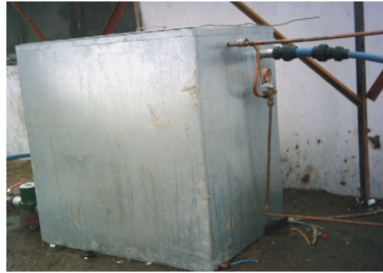
Şekil 4. Toprak Kaynaklı Buharlaştırıcı
