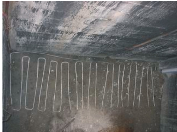
Şekil 5. Biyogaz Reaktörü İçerisine Yerleştirilen Yoğuşturucu
