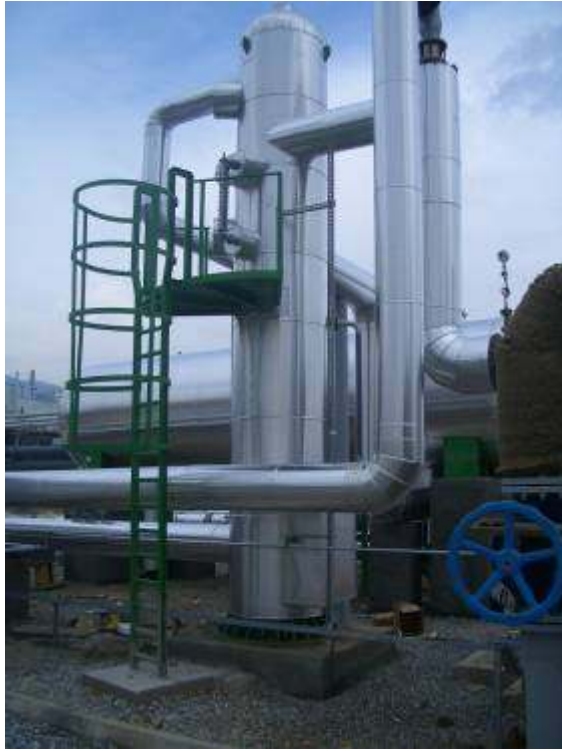
Şekil 11. a) Jeotermal Seperatör b) İşletme basınçlarına bağlı oluşan flaş buhar miktarları
