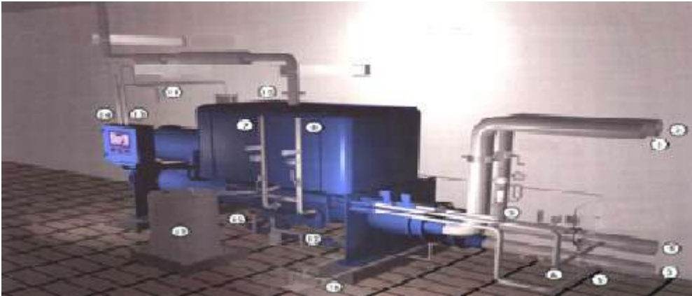
½ekil 10. Tipik su soğutmalı çiller montajı[2]
