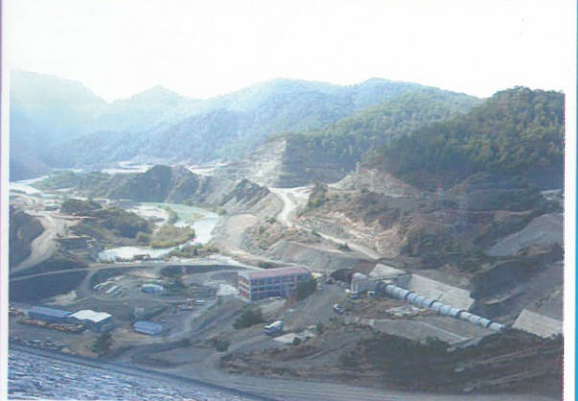
Aydın Temsilciliğimizden Akköprü Barajına Teknik Gezi
