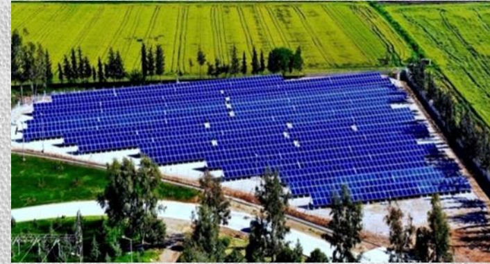
Adana Çimento Fab. 499 MW ık Pv sistemi.
