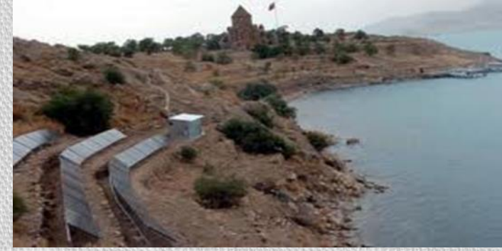
Van, Akdamar adası Pv sistemi
