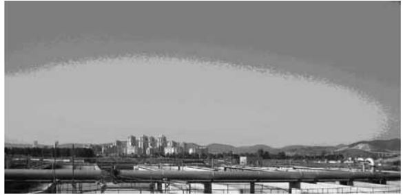
Havalandırma Tankları ve Hava Boruları
