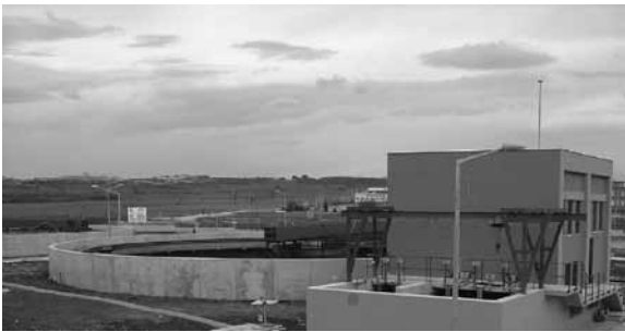
Geridevir Aktif Çamur Pompa İstasyonu
