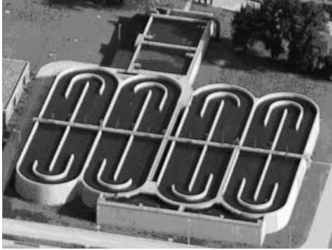
Selektör ve Anaerobik Bio-fosfor Tankları
