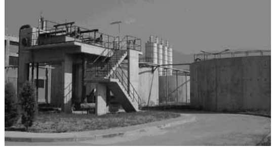
Çamur Izgara Yapısı ve Çamur Tankları
