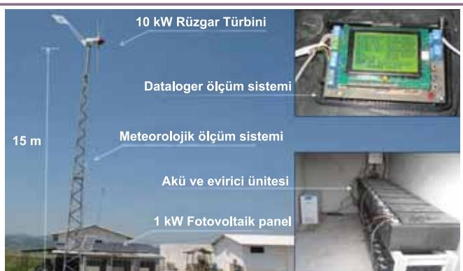
Şekil 6. Kurulu Birleşik Yenilenebilir Enerji Sistemi ve Ekipmanların Görünümü
