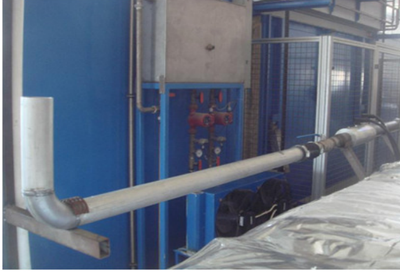
Şekil 2 Hava debisi ölçümünde kullanılan ventürimetre ve yerleşimi
