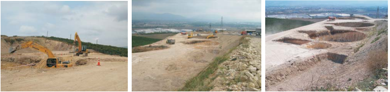
Şekil 8. Tesis Temel Kazı Çalışmaları
