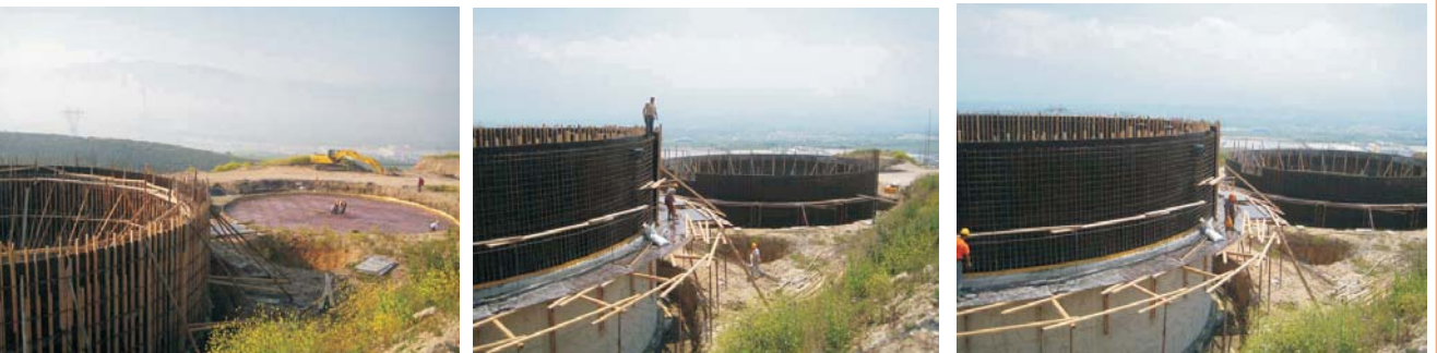
Şekil 9. Tesis İnşaat Çalışmaları
