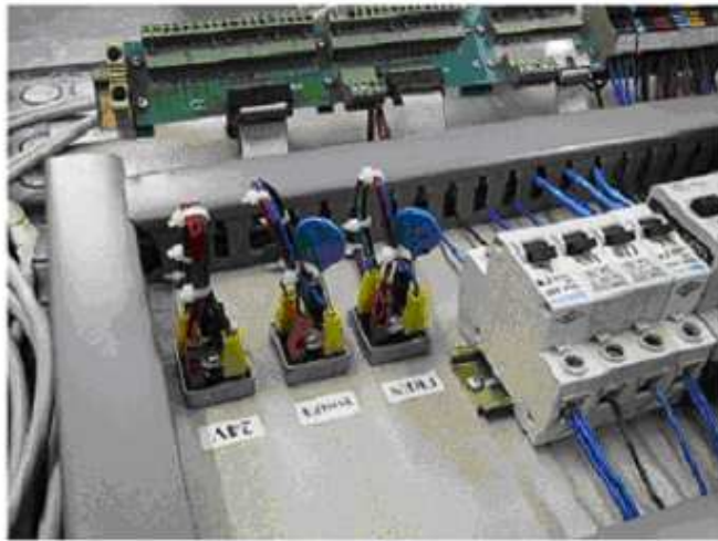
Şekil 3. Yıldırım Testi İçin Eklenen Varistörler
