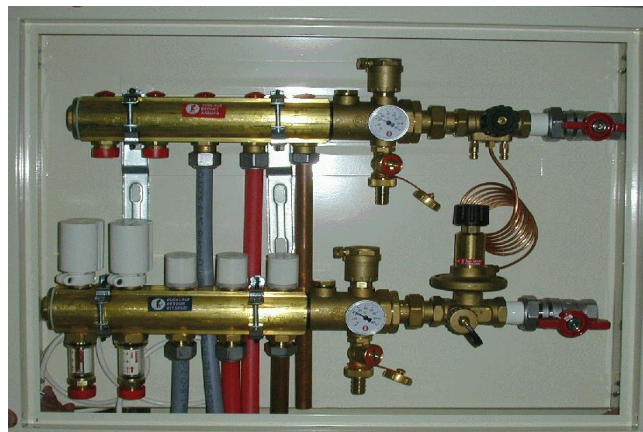
Resim 5. Yerden Isıtmada Fark Basınç Vanası Uygulaması [9]
