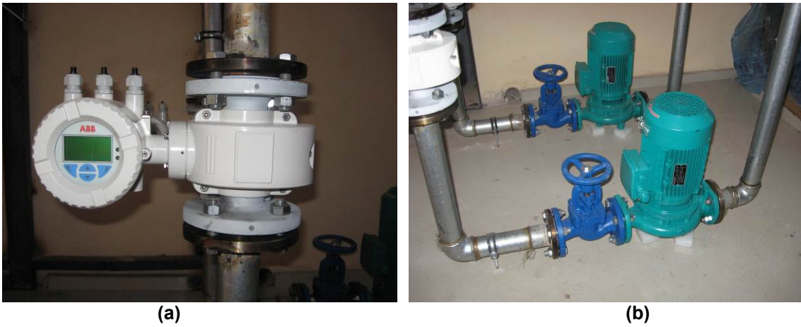
Şekil 8. Ölçüm Cihazları (a. Manyetik akış ölçer b. Pompalar ve debi ayar vanaları)
